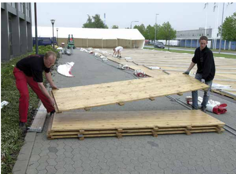
Vær to personer om håndtering af gulvpladerne, alt efter størrelse og vægt på disse. Tag endvidere gulvpladerne fra den rigtige vinkel, og undgå vrid i hoften i forbindelse med løft og transport heraf.
