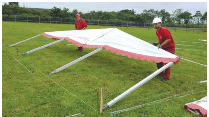
Som minimum skal der være en telmontør i hver side af teltet, når det rejses. Antallet af telmontører afhænger dog af teltets størrelse og muligheden for brug af hjælpemidler.
