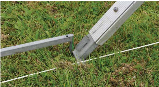
Lad benet på spæret, der rejses, støtte på den ås, der er monteret på tidligere rejste spær. Derved undgås skrid og uforudset belastning for telmontøren.
