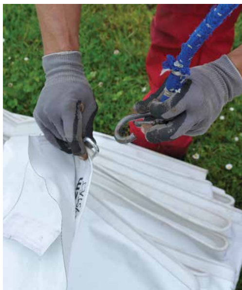
Ved montering af tagdug kastes trækreb i første omgang over teltkonstruktionen, retter monteres ved første tagdug og bruges efterfølgende til at trække tovene over igen. Dermed undgås belastende vrid og belastninger i skulderen.
