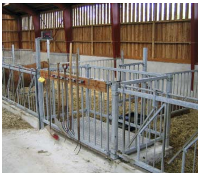
Vægt indbygget i kødkvægsstald. Dyrene kan drives igennem fra boks til boks.
