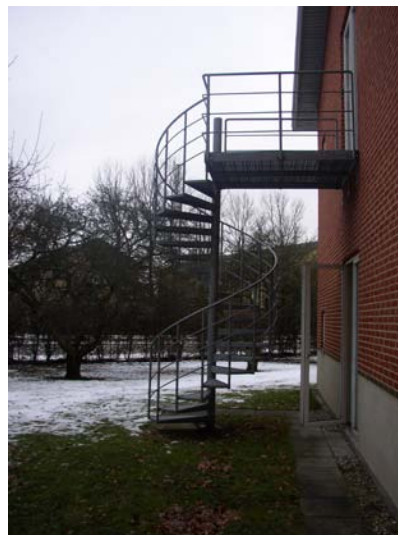
Udvendig brandtrappe - spindeltrappe
