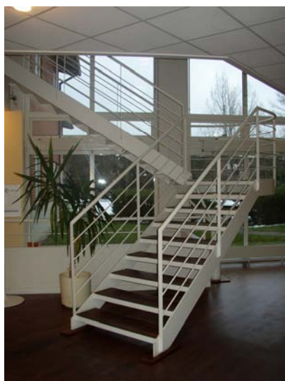
Indvendig trætrappe - lige forløb
