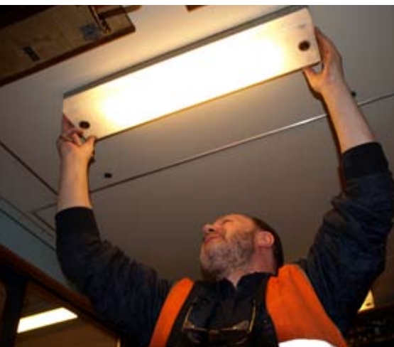
Udskiftning af pærer i loftlamper.
